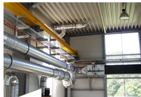
Luftkreislauf mit Heiz-/Kühlregister
