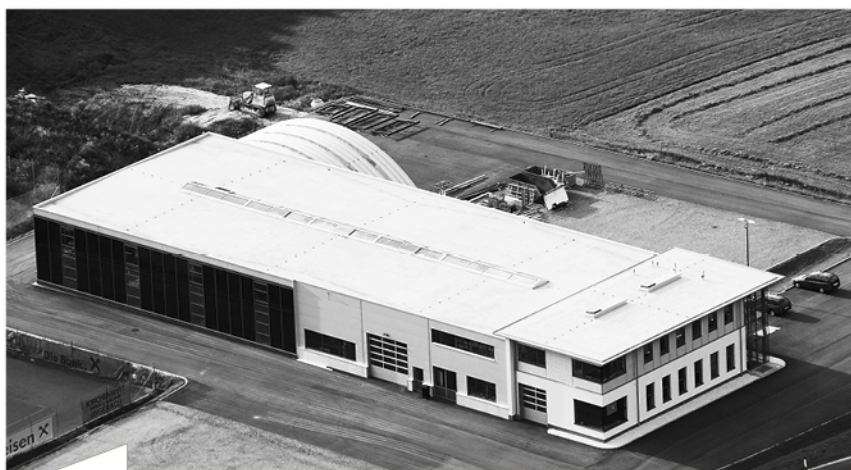
Das Betriebsgelände der Unimet Metallbau liegt in Ungenach, ein beschauliches Dorf am Rande des Salzkammerguts.
