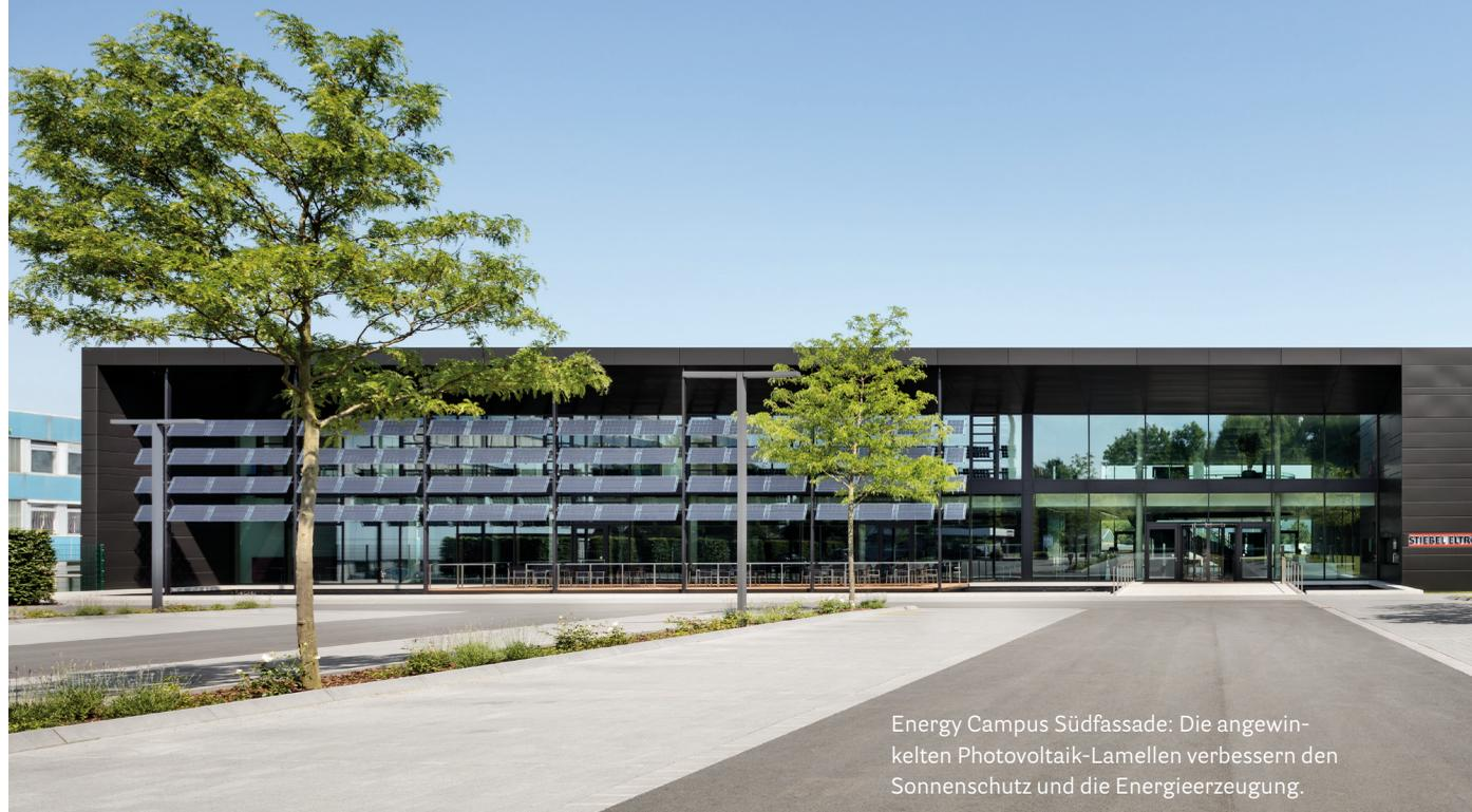
Energy Campus Südfassade: Die angewinkelten Photovoltaik-Lamellen verbessern den Sonnenschutz und die Energieerzeugung.
