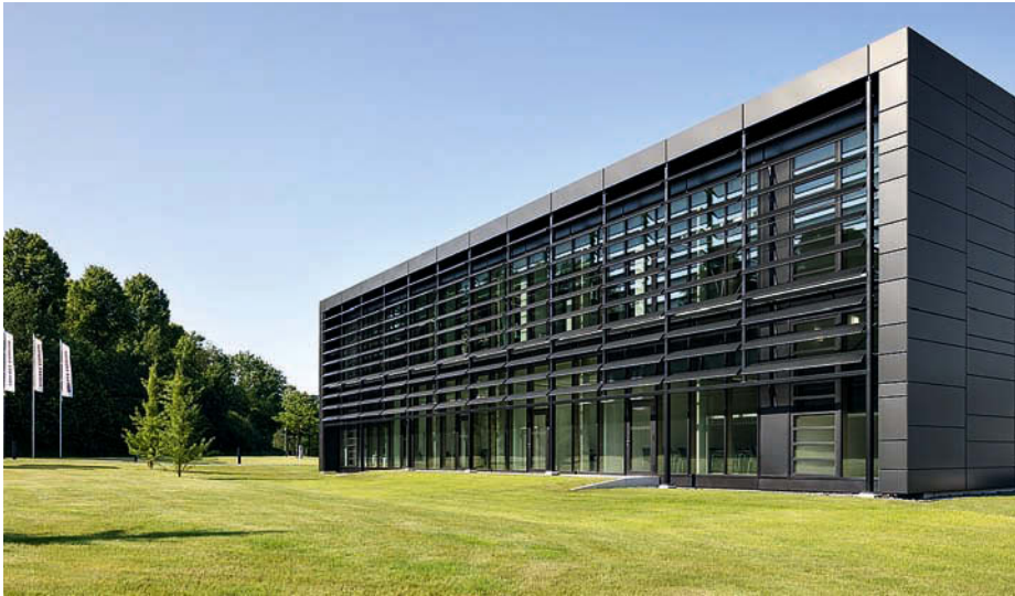
Ostfassade: Der große Glasanteil der P/R-Fassade wird durch das Alu-Lamellensystem vor zu großen Strahlungslasten abgeschirmt.
