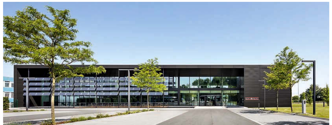
Ansicht der Südfassade des Energy Campus. Die angewinkelten PV-Lamellen sind zur Sonne ausgerichtet, verbessern damit Sonnenschutz und Energieerzeugung.
