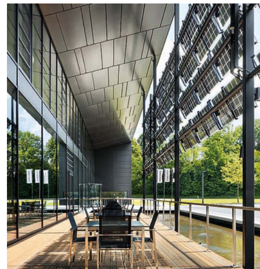
Filigrane Halterung der Spezial-PV-Lamellen. Die drehbare Unterkonstruktion überzeugt mit ihrer Leichtigkeit.
