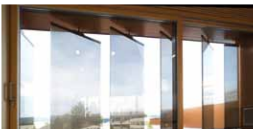
RHZ / Terrassenbereich: 1150 mm breite Lamellen ermöglichen Durchgang.
