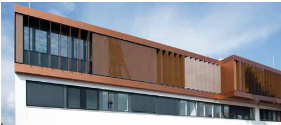
Nordost-Ansicht der RHZ Bau GmbH. Lebhaftes Bild durch manuellen Steuerungseingriff.
